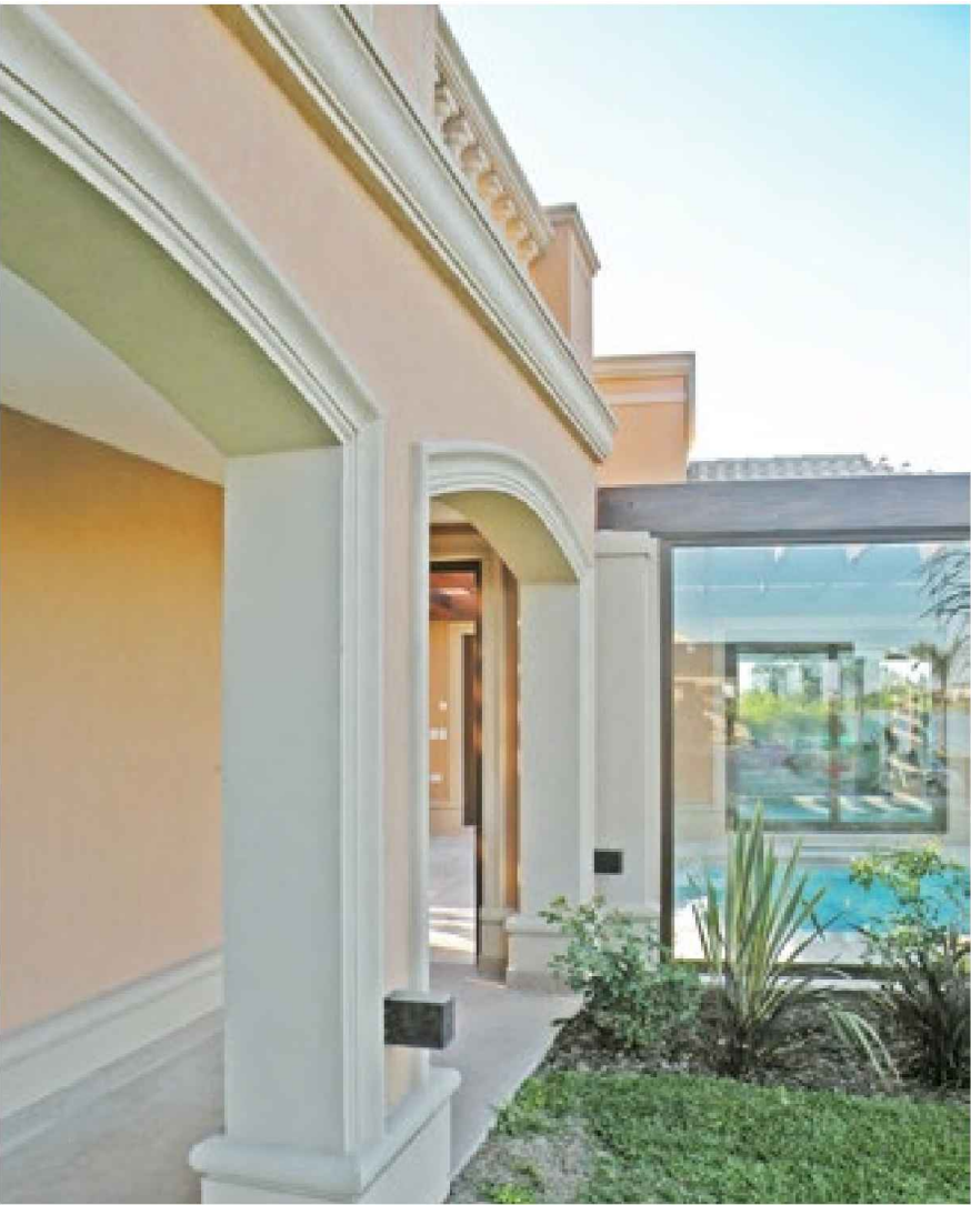
Acceso a la pileta / Pool access
