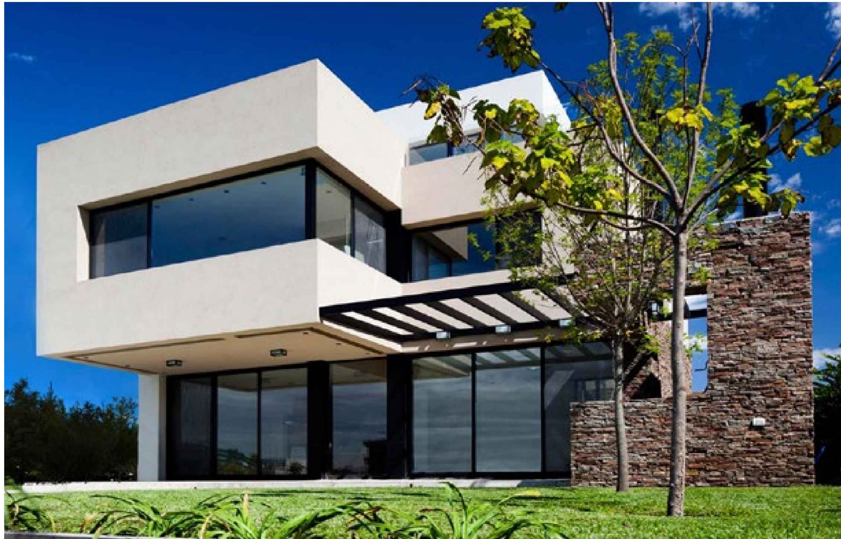
Vista contrafrente derecha / Right back view
