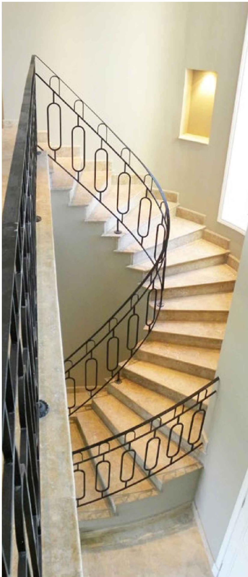
Escalera desde primer piso / Staircase from first floor
